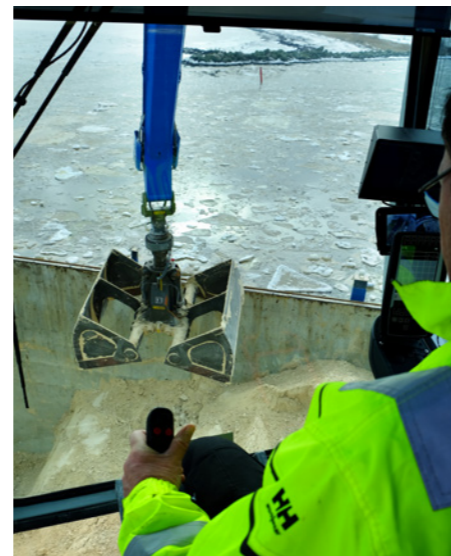
Den stora skopan tar 6 kubikmeter gips i varje lyft, det är nästan 15 ton.
